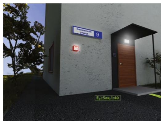
снаружи перед каждым конечным выходом из здания
